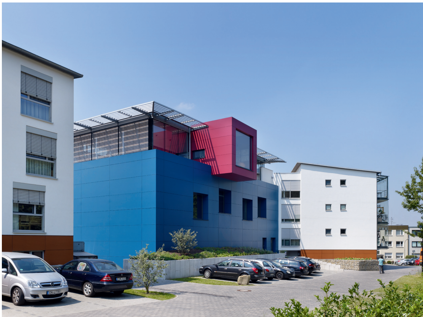
Auf die vorhandene Gebäudesubstanz des Schwimmbades (Blue Box) wurde das Architekturbüro in Stahl-/Glaskonstruktion aufgesetzt.
