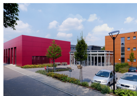
Auf die vorhandene Gebäudesubstanz des Schwimmbades (Blue Box) wurde das Architekturbüro in Stahl-/Glaskonstruktion aufgesetzt.
